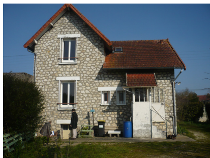
Avant et après la réalisation d'une extension de 70m 2 pour valoriser ce bien immobilier -Agence Cybel Extension Montargis
