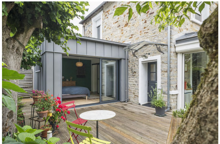
Un habillage en zinc quartz pour une extension ouverte sur l'espace jardin - ©Cybel Extension
