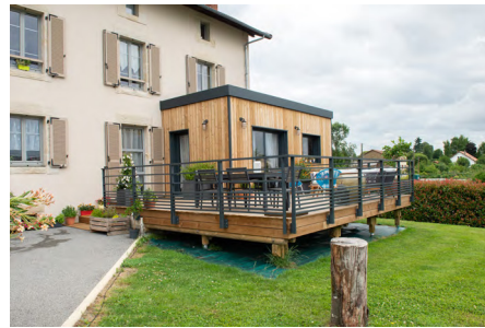
Extension de maison à Limoges
