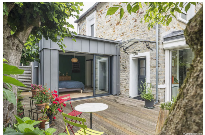
Exemple d'extension près de Rennes © Cybel Extension
